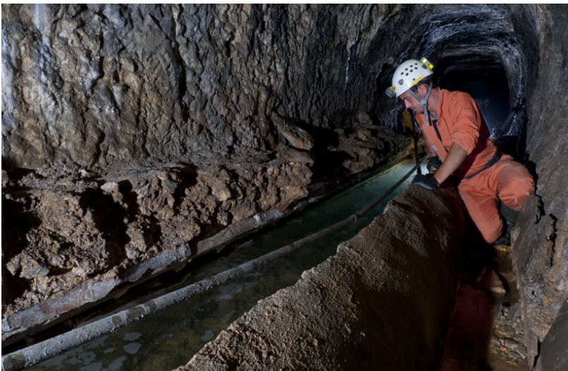
Foto n. 6: particolare della galleria dell'acquedotto
